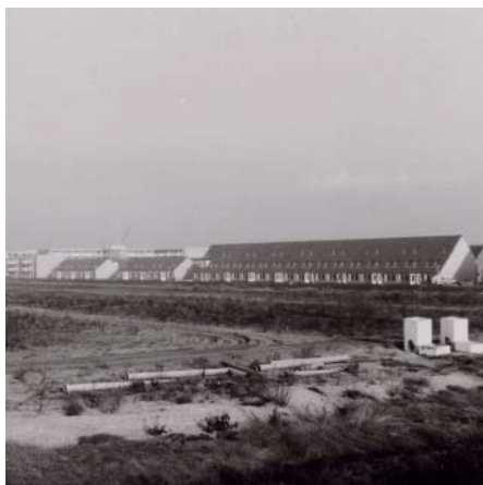
De Purmer-Zuid in aanbouw, jaren '80. Bron: Waterlands archief
