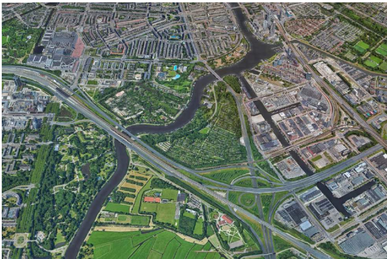
Luchtfoto van het plangebied (bron: google maps)
