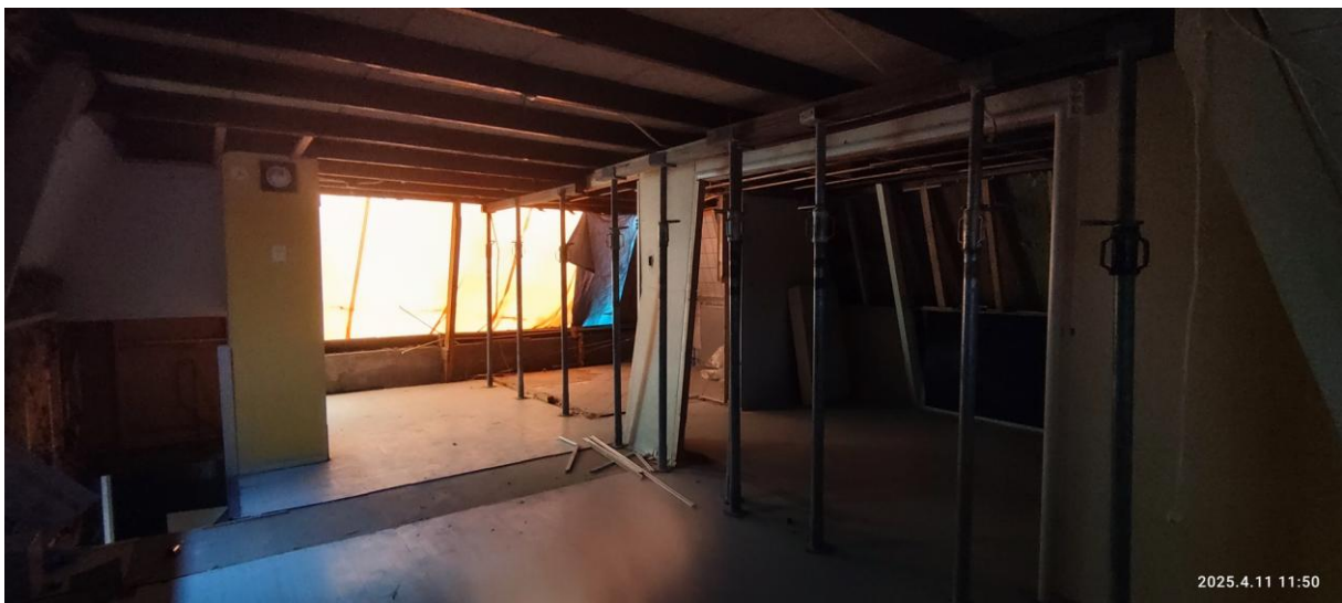
Foto Gehele eerste verdieping die is afgebroken.
